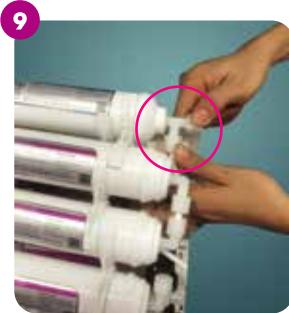
Tại cút đầu ra của màng RO (cút kết nối với dây màu xanh) tháo rời dây màu xanh sau đó đấu nối đoạn dây RO nhỏ (dây rời ở bên ngoài) tại vị trí này rồi dòng ra nút xả nước quy định.
