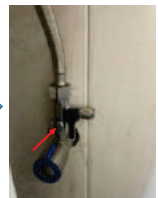
5. Lắp van cấp nước vào đường ống nước máy. Lực mô men xoắn của đai ốc là khoảng 3,2N/m.
