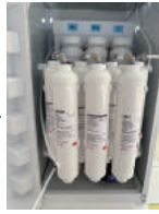
22. Mở van cấp nước. Để nước xả qua bộ lọc trong khoảng 10 phút.
