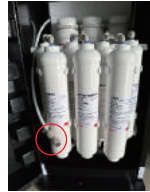
13. Lắp đầu nối nhanh vào ống nhựa PE.
