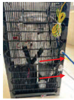
8. Lắp ống nhựa PE từ van cấp nước đến ngò vào ống trên máy, rồi lắp thêm ống cho ngò xả nước.
