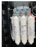
17. Rút ống nhựa PE ra khỏi đầu ra của bộ lọc nano bạc-T33.
