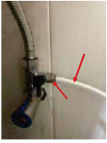
6. Nối ống nhựa PE với bộ van cấp nước. Siết chặt để đai ốc không bị xoay.
